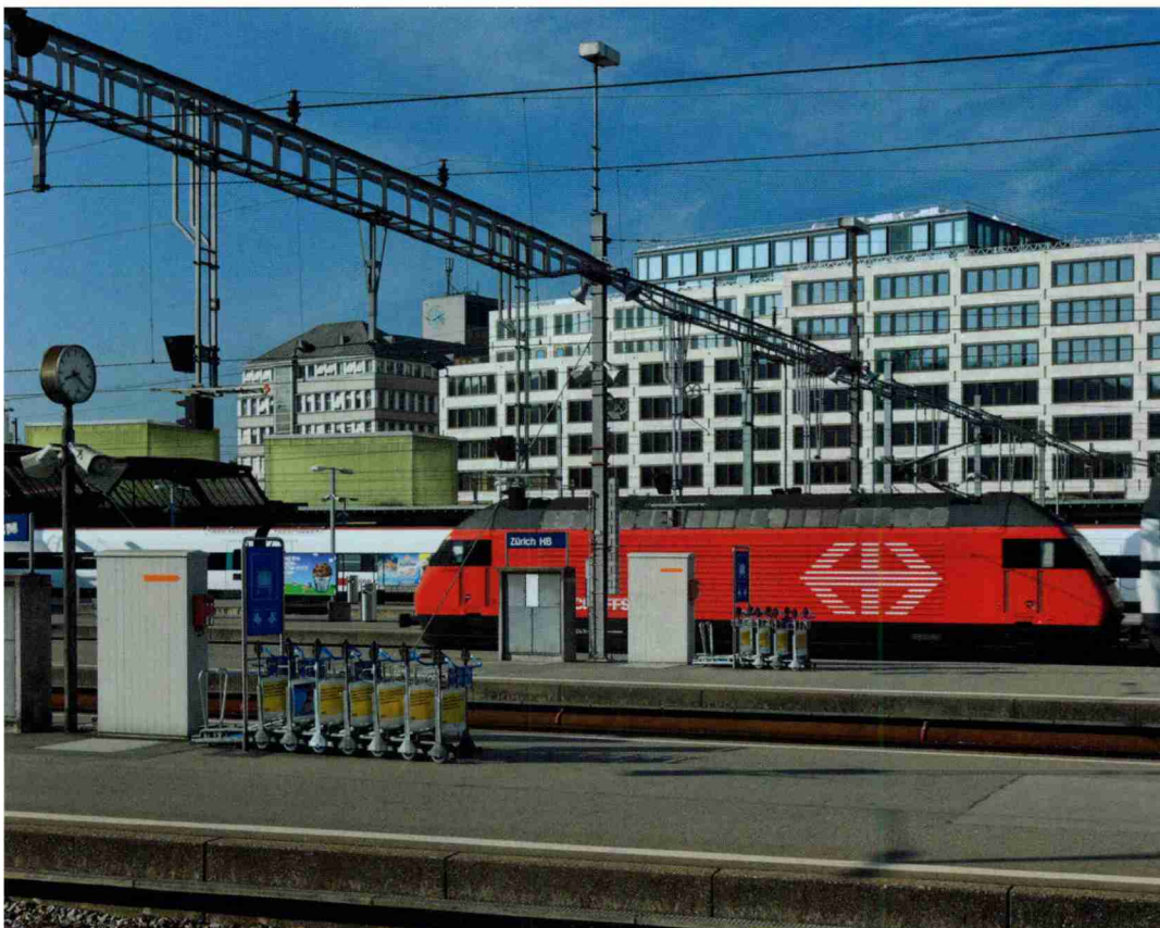
Direkt am Zürcher Hauptbahnhof: Das Baufeld A des Projektes Europaallee, das planmässig im Sommer 2012 abgeschlossen sein wird.
