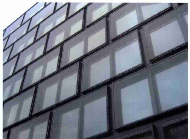
Die Glasfassade im Baukastensystem wurde in gerüstloser Montage schnell und geräuscharm eingehängt und verschraubt.
