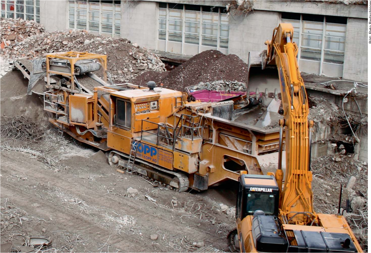
Die Brechmaschine separiert Stahl und Beton und zerteilt letzteren in faustgrosse Stücke. Pneulader sorgen für den Verlad in die bereitstehenden Güterwaggons. Bild unten: Die Fassade der Sihlpost fällt.
