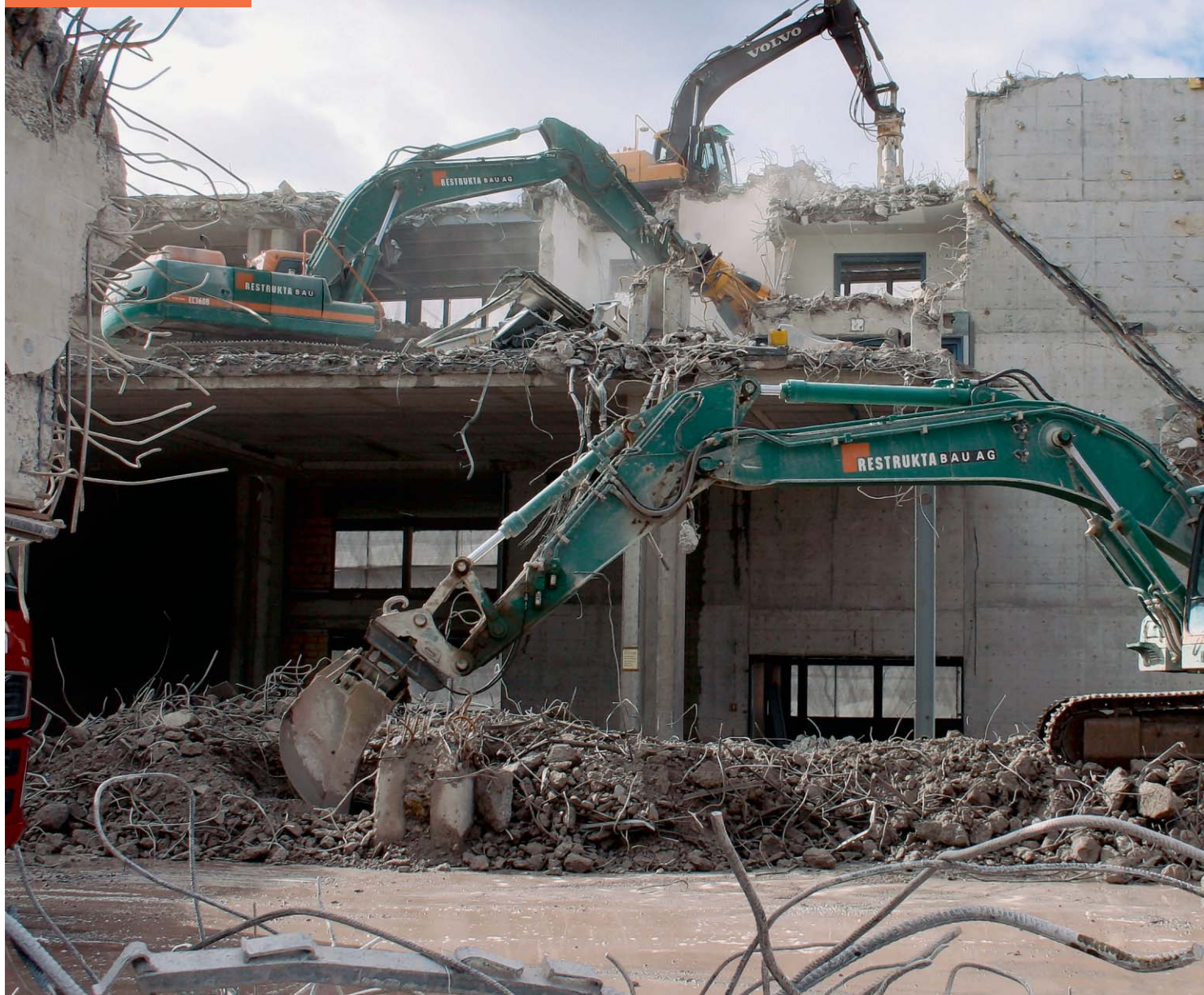
Auf praktisch allen Ebenen arbeiten die insgesamt 17 Bagger am Rückbau des Verteilzentrums Sihlpost.
